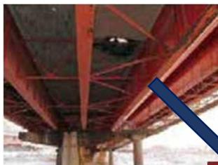
重量オーバーの車が通行したため、床版（車両を直接支える部材）に穴が開いてしまった事例です。
